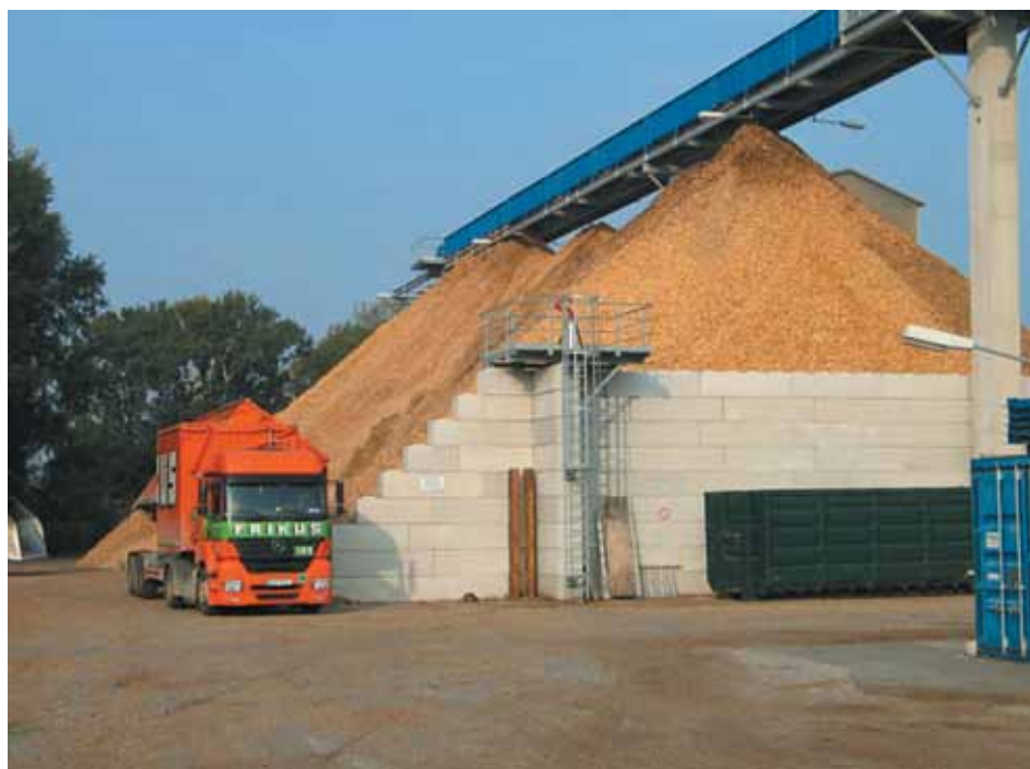
Rycina 4. Pryzma zrębków powstałych na terminalu zbiorczym przeznaczonych do spalania w elektrociepłowni
